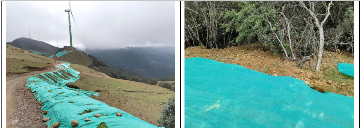
图 4.3-2 道路工程区临时措施实施情况
