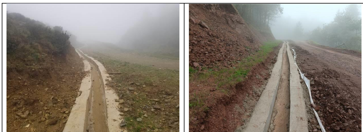
混凝土排水沟（施工期间）
