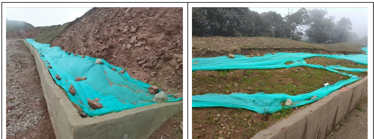
图4.3-3 集电线路工程区临时措施实施情况
