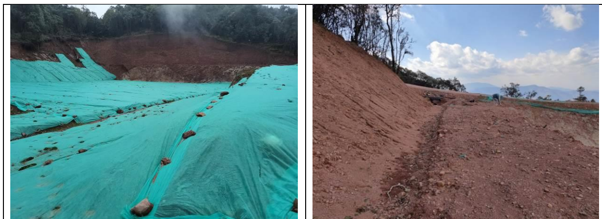
图 4.3-4 施工场地区临时措施实施情况
