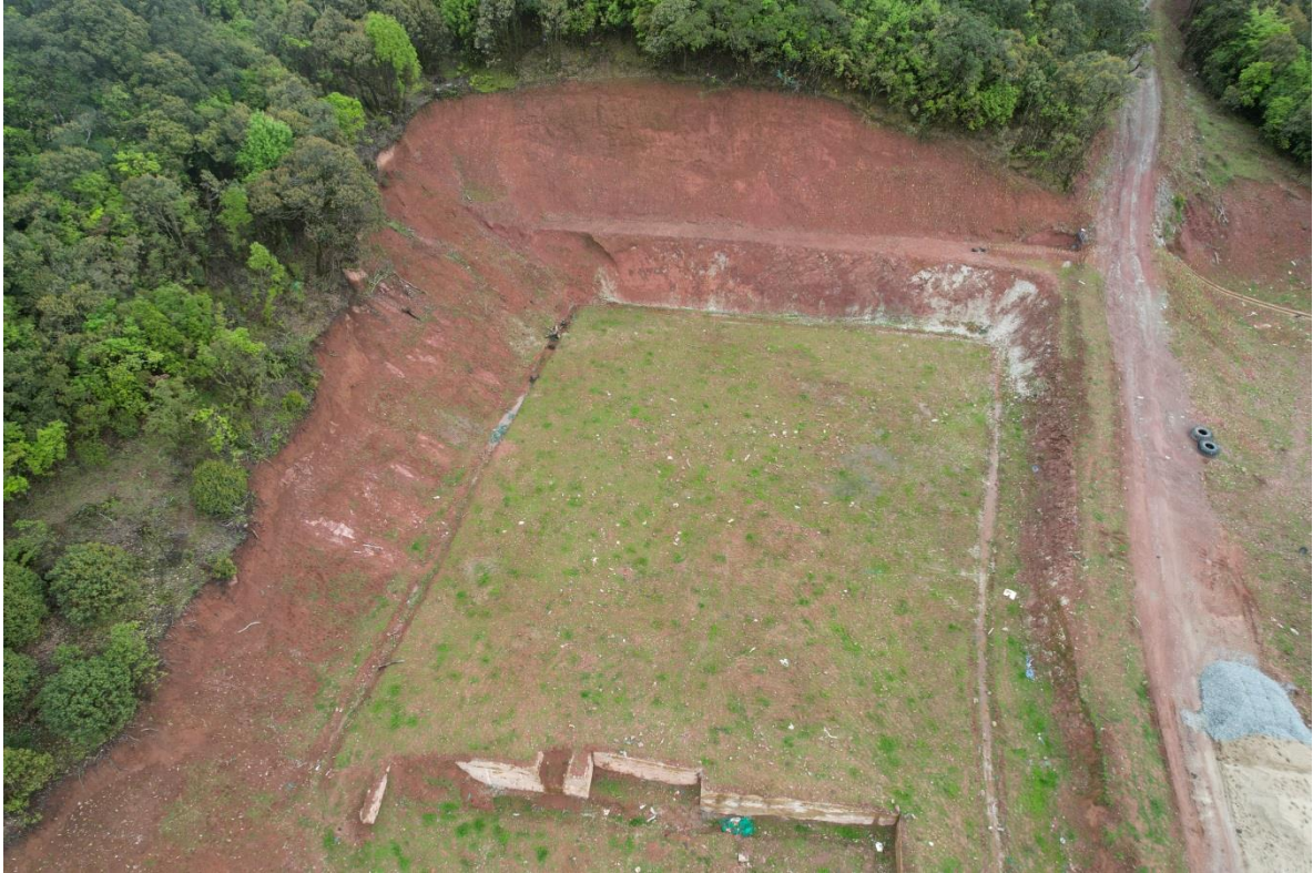
图 1.1-5 启用的 1 处施工场地
