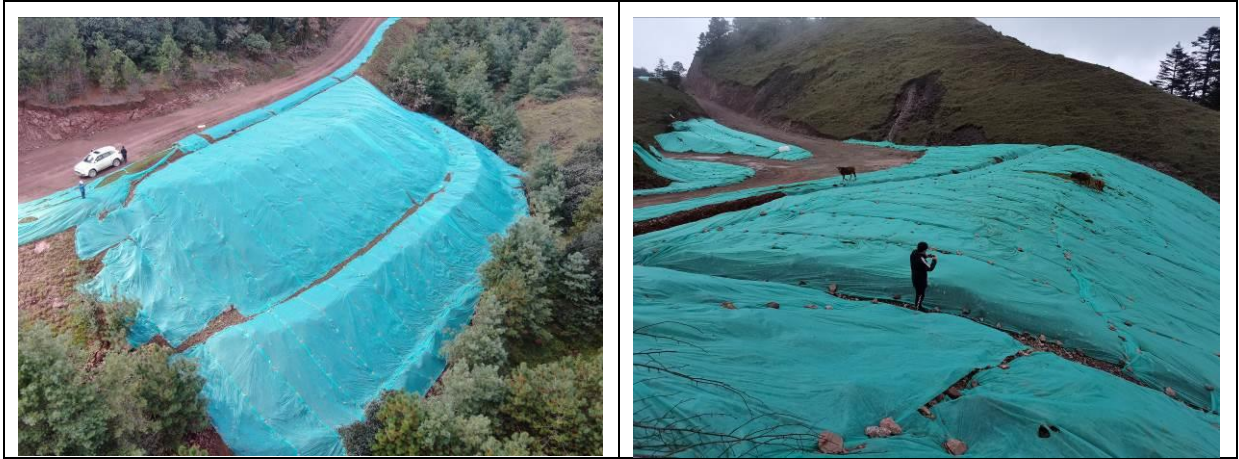
图 4.3-5 弃渣场区临时措施实施情况
