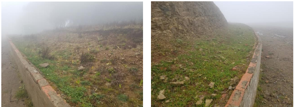
图 1.1-4 集电线路现状
