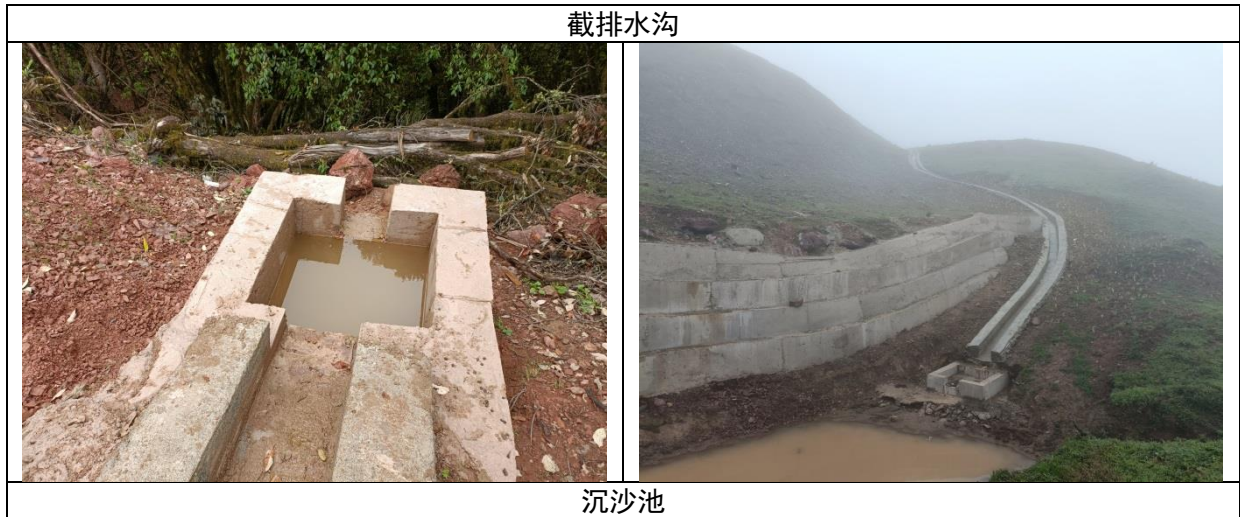
图 4.1-4 工程措施实施情况
