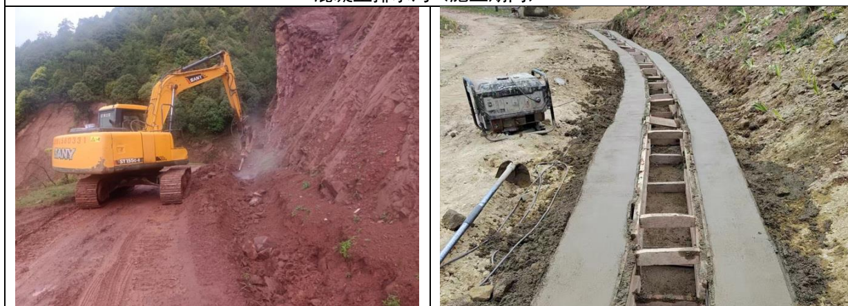
排水沟开挖及衬砌（施工期间）
